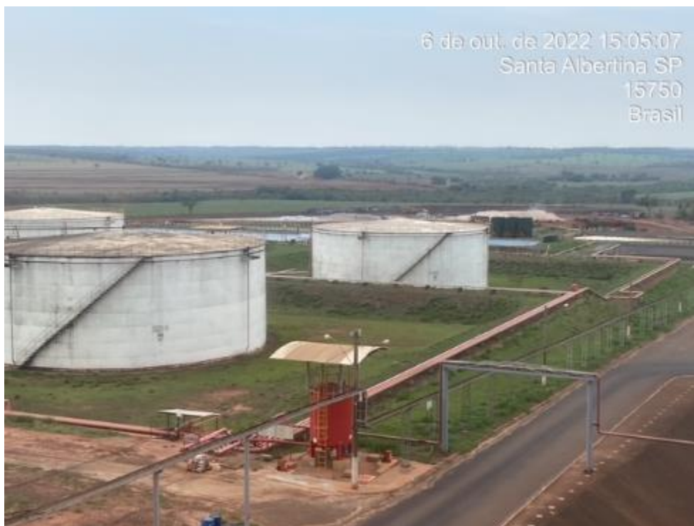
Figura 8. Vista geral dos tanques de armazenamento de etanol.
