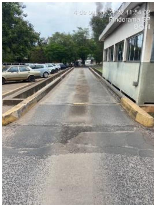
Figura 1. Balança de pesagem de caminhões de cana
