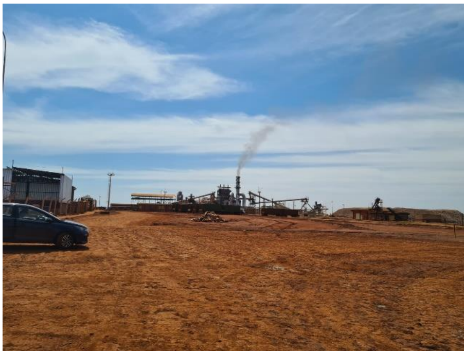
Foto 1: Vista Geral da Usina Rio Dourado
