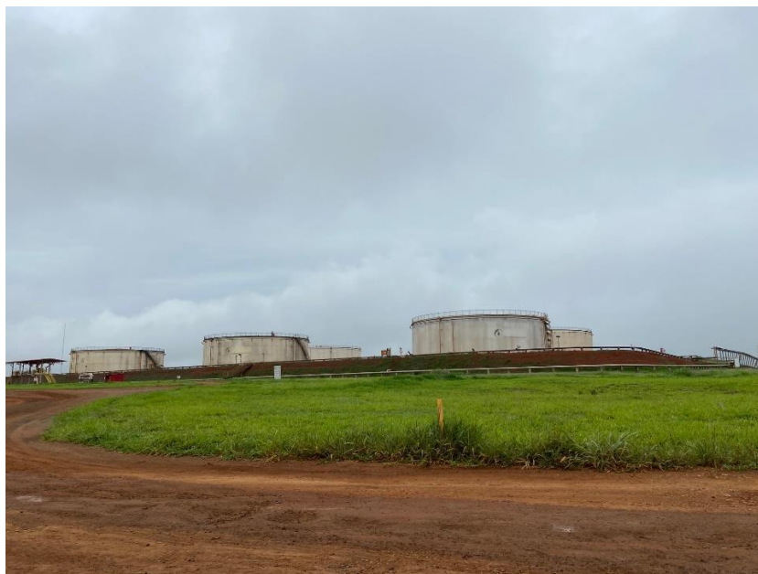
Foto 3: Tanques de Armazenamento do Produto Acabado
