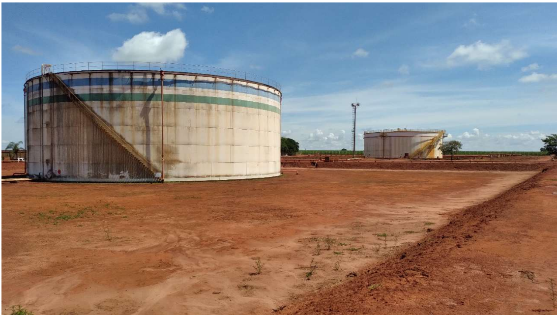
Foto 3: Tanques de armazenamento de álcool.
