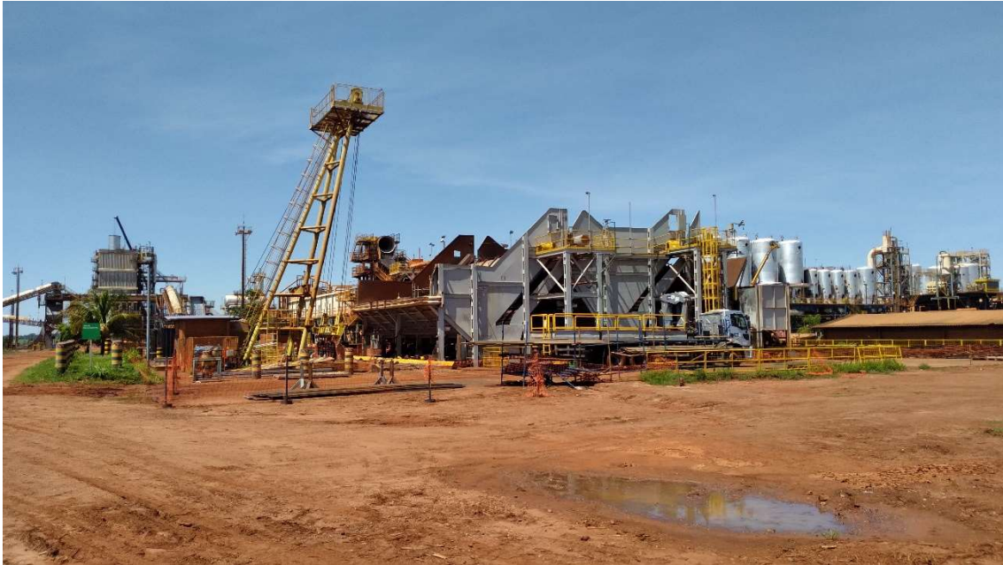
Foto 2: Vista da usina
