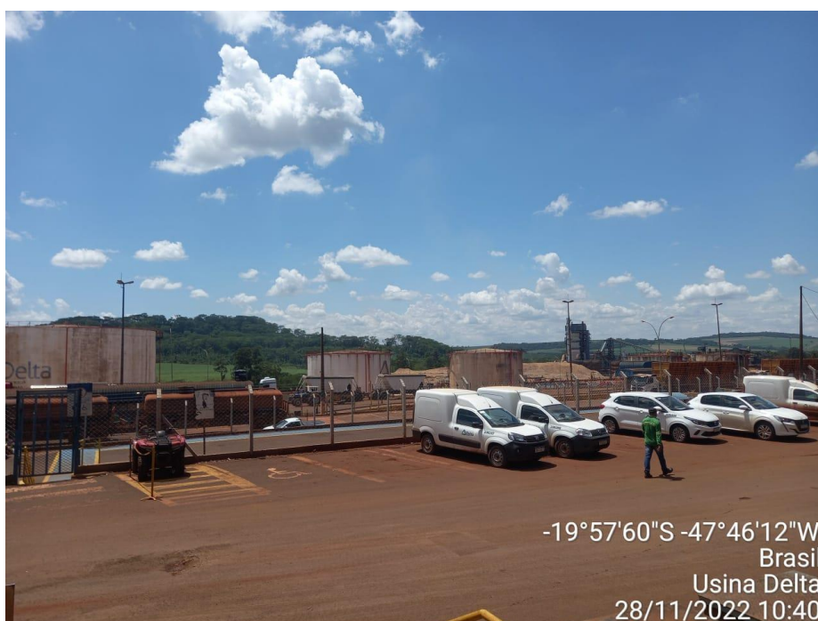
Figura 3. Tanques de Armazenamento
