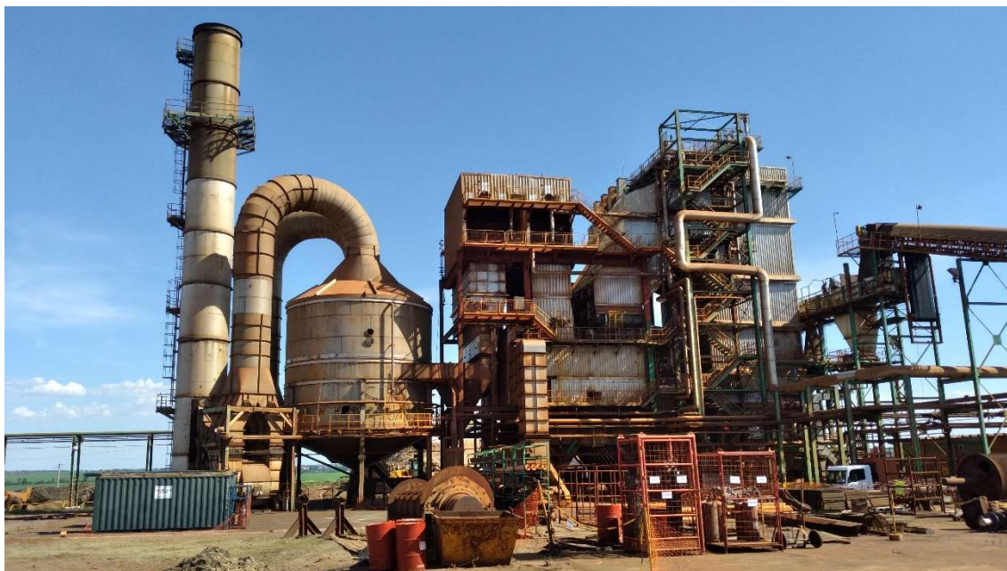
Foto 2: Caldeira da usina
