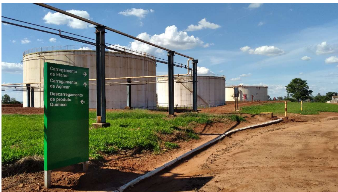
Foto 1: Tanques de armazenamento de álcool.
