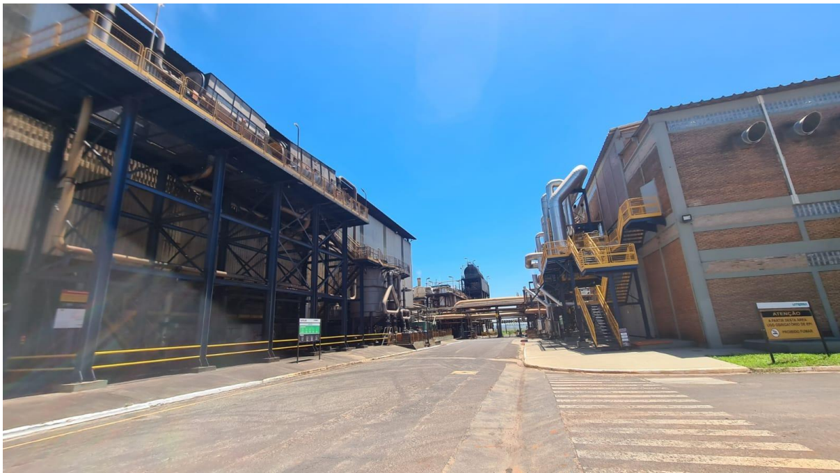
Planta Industrial – Usina Viterro – Unidade Rio Vermelho
