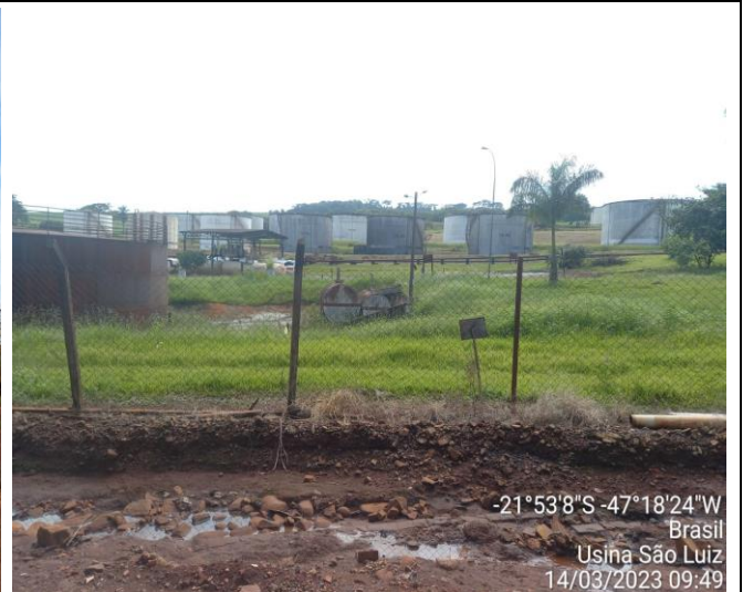
Foto 10. Tanques de Armazenamento de Etanol
