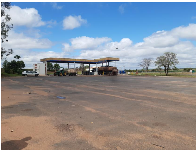
Foto 2. Posto de Combustível
