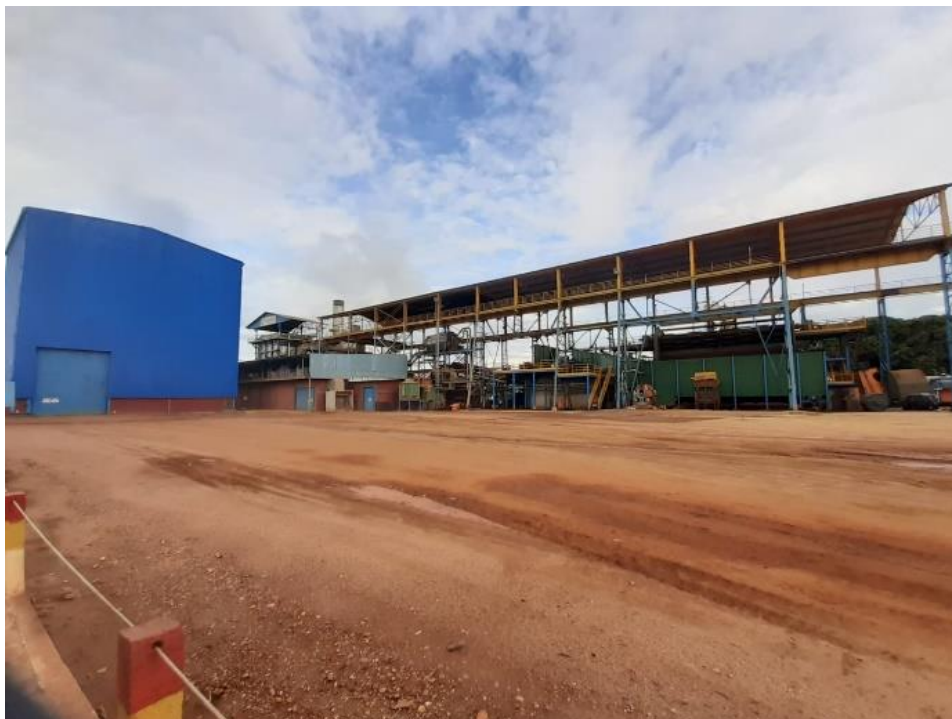
Foto 2. Visão Geral da Usina
