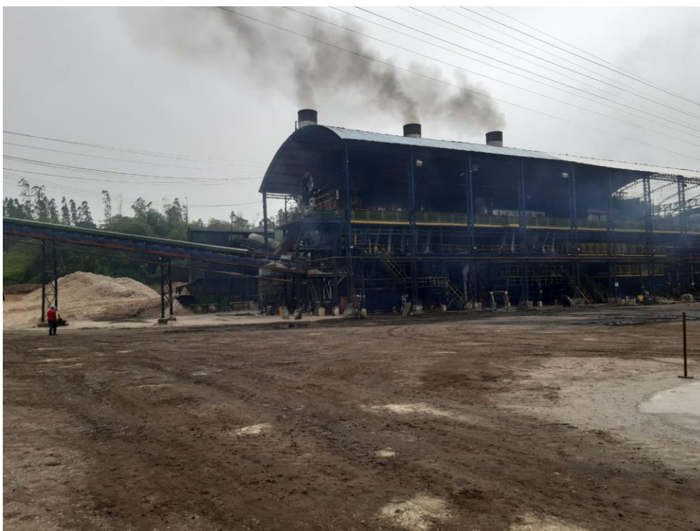
Foto 1 – Visão geral da Usina.
