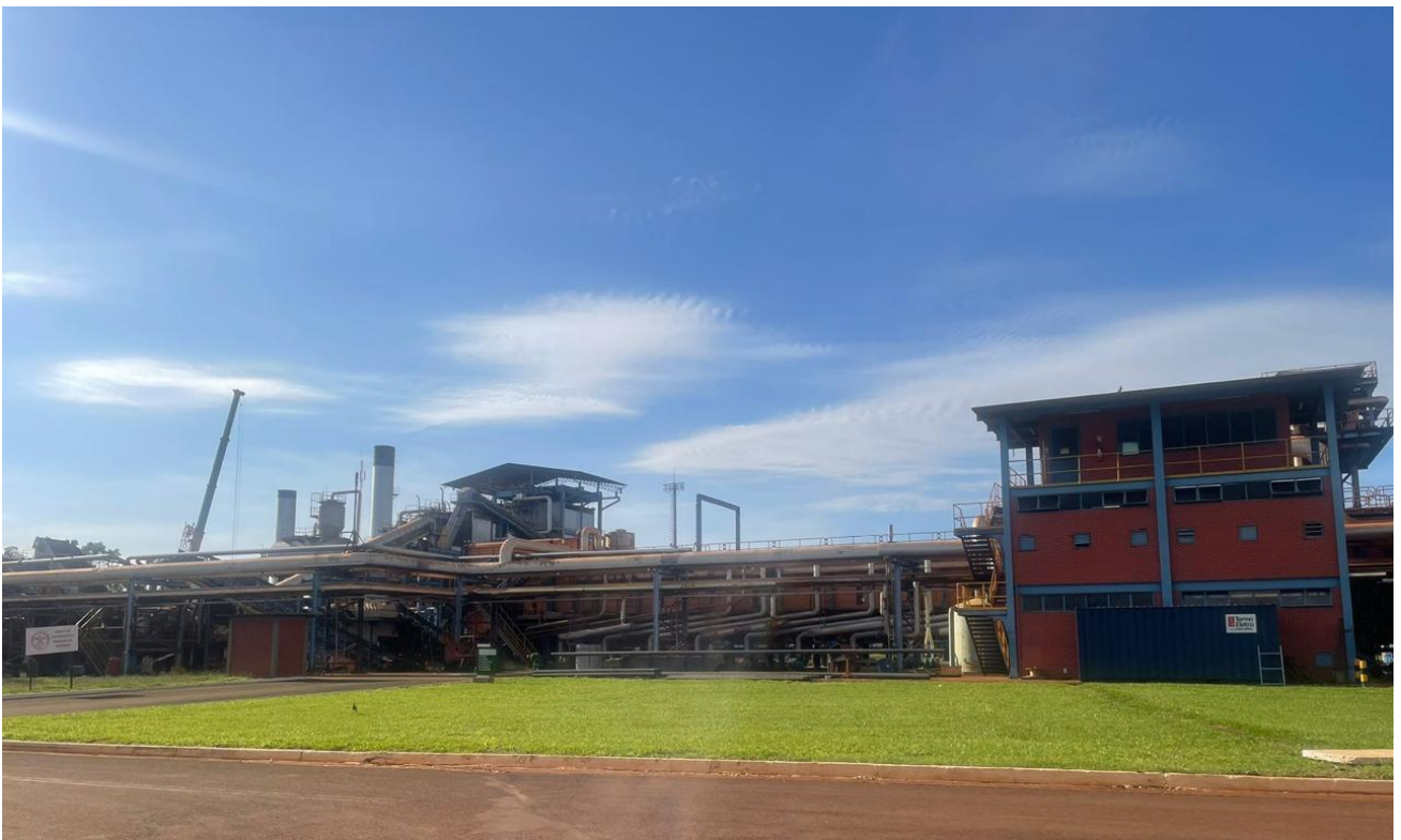
Foto 4. Visão geral da unidade
