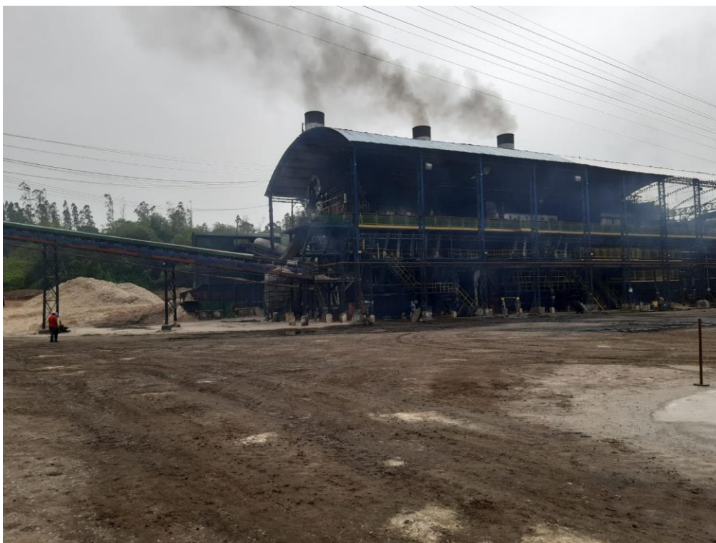
Foto 1 – Visão geral da Usina.
