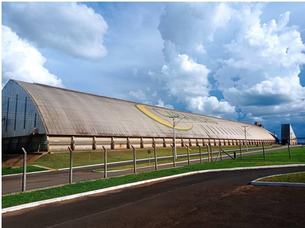
Vista do armazém, em 08 de dezembro de 2022, Ipameri, GO.
